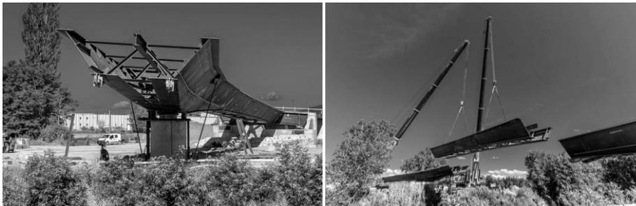
**Fig. 12.** Fasi di montaggio dell'impalcato
